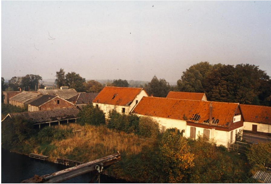
1980 Houtloodsen en gebouwen wed. P. de Jongh erachter vóór de renovatie
