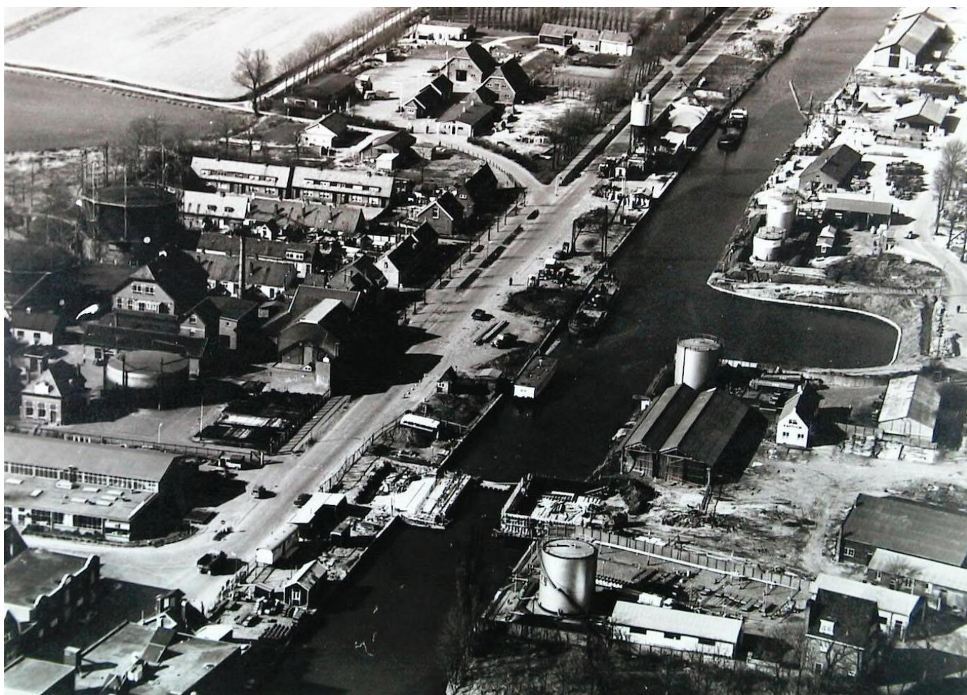
1965 Luchtfoto vanuit het zuiden tijdens de aanleg van de Ringbrug. Gemeentewerken, de Goese Jordaan, een deel van de gasfabriek en het weeghuisje zijn nog aanwezig. De zwaaihoek is er al.
